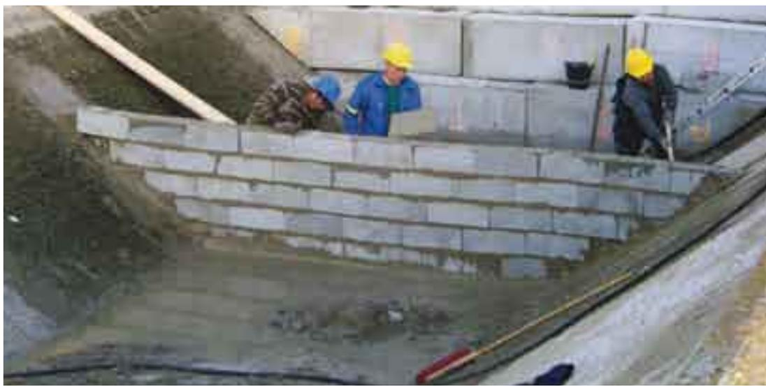
Le ciment naturel permet des remises en service rapides des ouvrages hydrauliques.
