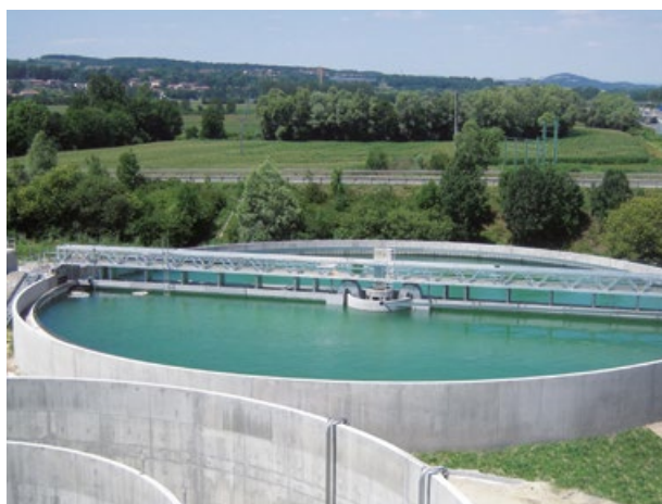
STATION D'ÉPURATION Bourgoin-Jallieu (Isère)
