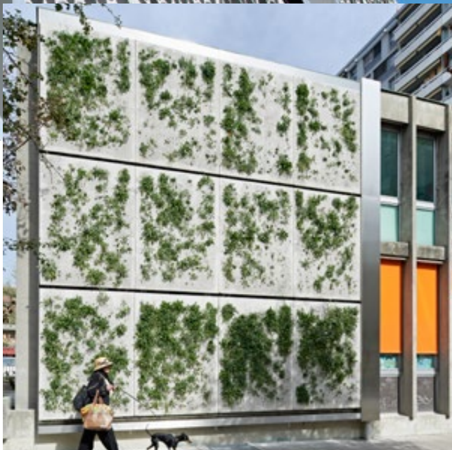
PAROI VÉGÉTALE SKYFLOR® Genève (Suisse)
