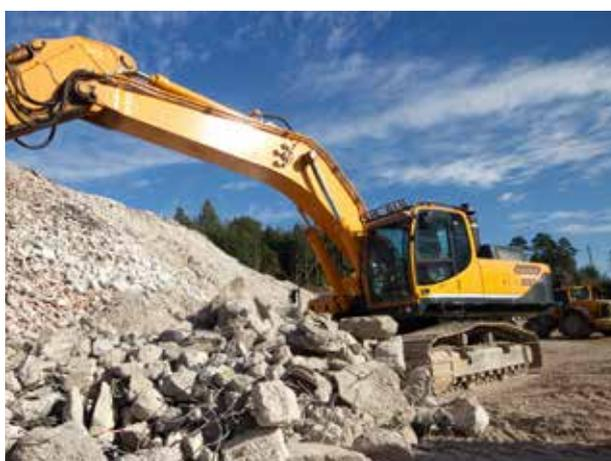
RECUPERO DEI GRANULATI RICICLATI DERIVANTI DA DEMOLIZIONE
