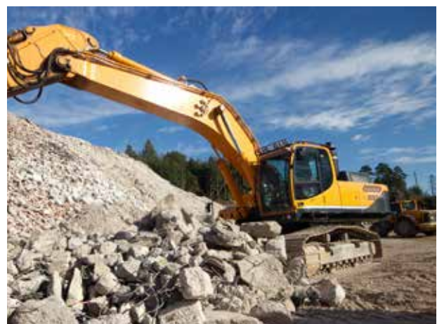
HERGEBUIK VAN GERECYCLEDE GRANULATEN UIT BOUW- EN SLOOPAFVAL Jassans (Ain)
