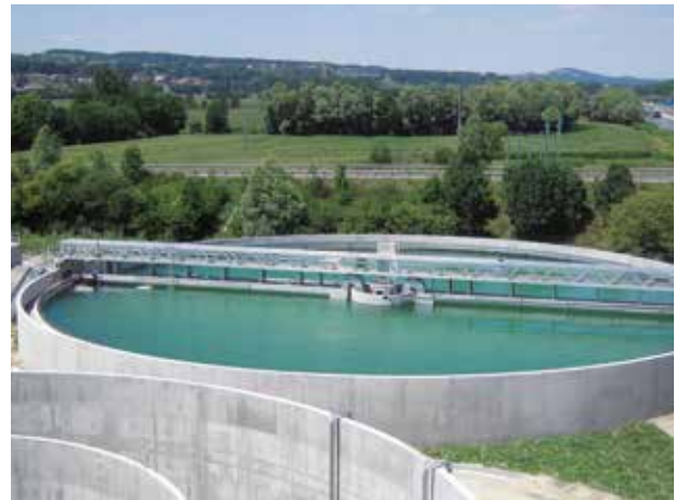
ZUIVERINGSSTATION Bourgoin-Jallieu (Isère)
