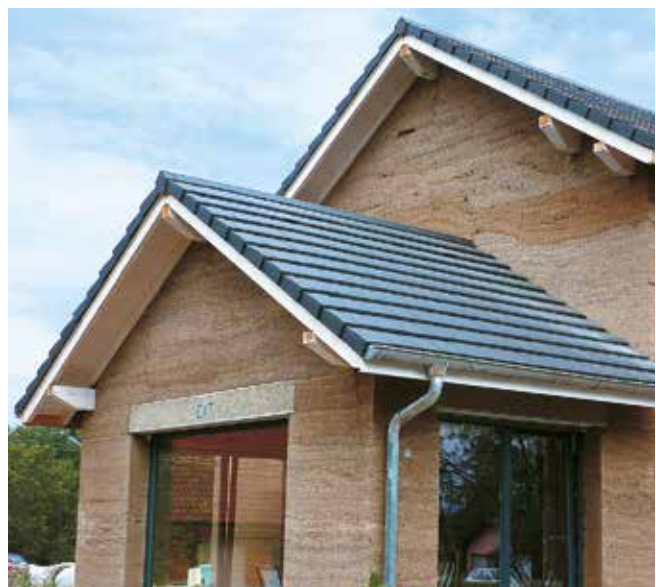
HEMPCRETE HOUSE Arbusigny (Haute-Savoie)
