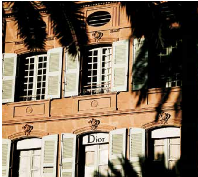
FASSADENRESTAURIERUNG DER BOTSCHAFTSVILLA DIOR-GESCHÄFT Saint-Tropez (83) – A Architekturbüro LAC – Baufirma Les Ateliers du Paysage
